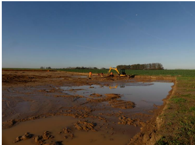
vue partielle de la fouille © Inrap
